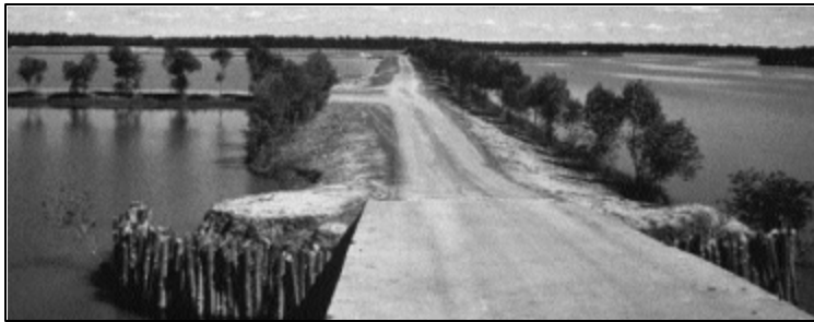
Figura 7-1 Un ejemplo del uso de mangles para prevenir la erosión a lo largo de los caminos y los diques 14 .
