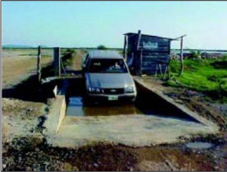
Figura 7-2 Un ejemplo de una estación de limpieza de vehículos en una finca de camarón 15 .
