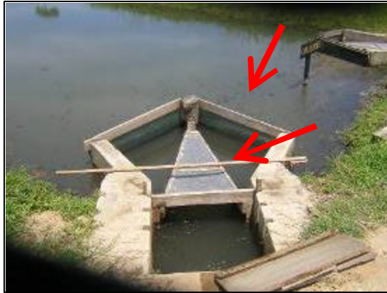
Figura 7-5 Un sistema de doble filtración con múltiples filtros son colocados en las compuertas de entrada.
