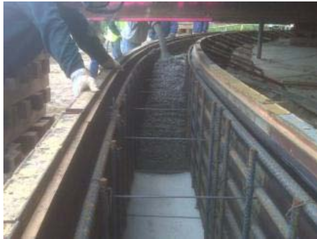
Figure 12: Tank #2 Concrete Pour
