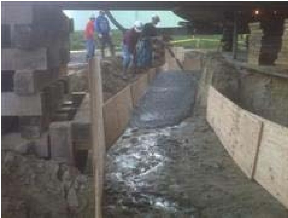
Figure 10: Concrete Pour
