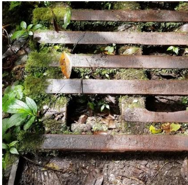
Figure A18. Unnamed Bridge, Del Bajo
