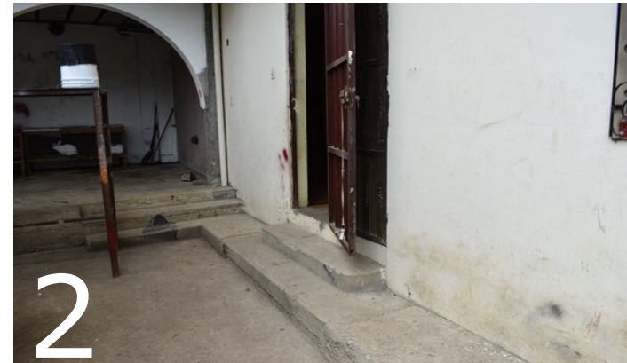
2 Para entrar, hay tres pasos que conducen a una entrada amplia. En el interior, hay muchas sillas y una mesa, con mucho espacio operativo en un piso de madera plano.
