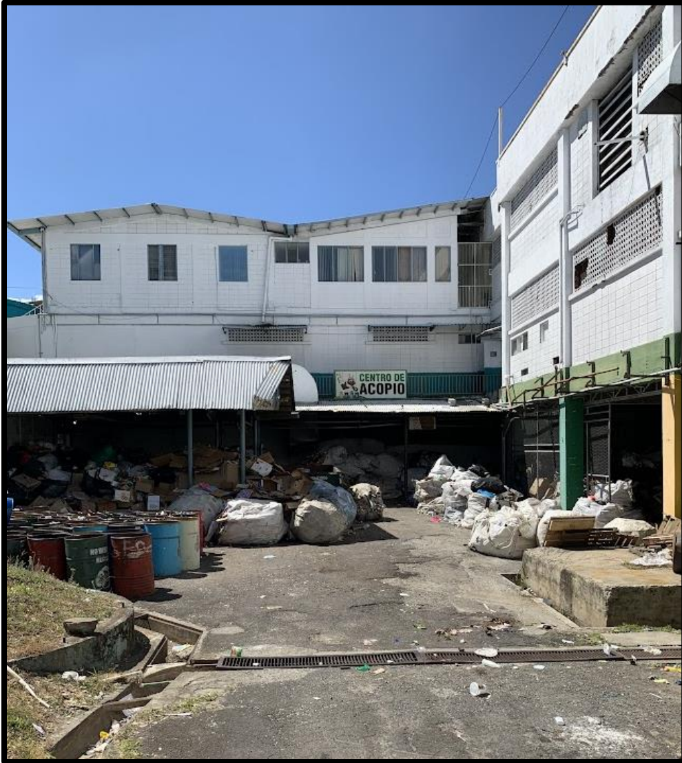
Figure 5: El Centro de Acopio (Collection Center) Exterior.
