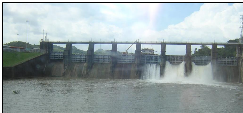
Figure 39: Miraflores Dam (Mitch, 2007)
