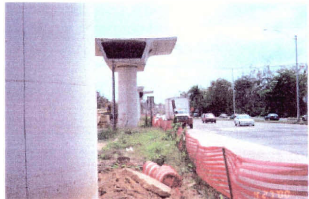
Tren Urbano Construction and PRI
