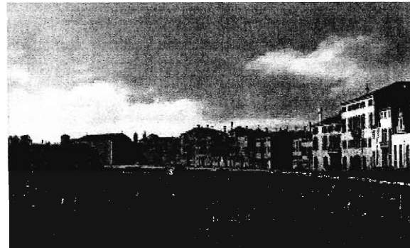
Figure 50 - Canale di Sta Chiara: Looking South-East along the Fondamenta della Croce (unknown)
