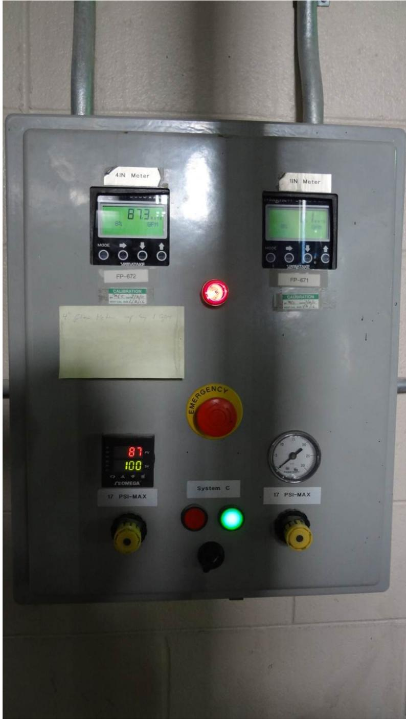
Figure 43: Flow Meter Display
