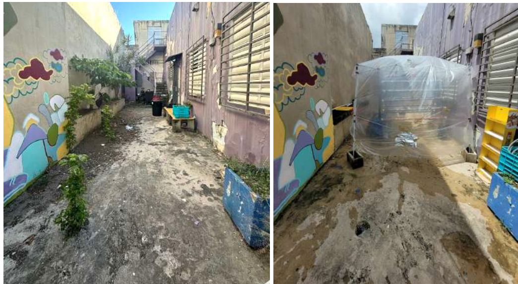
Figura 10: El callejón al lado del centro comunitario de Gandul antes de la construcción (izquierda) y después de la construcción hidropónica (derecha)
