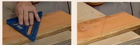
Եռանկյուն քանոնը դնում ենք կետի մոտ ու 45 աստիճան անկյան տակ գիծ ենք գծում
