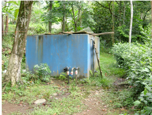
Figure 12: Water Filtration System at Proyecto Tilapia AMUCHI
