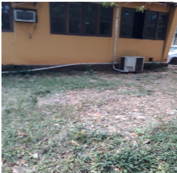
cámara séptica y pozo ciego del edificio académico
