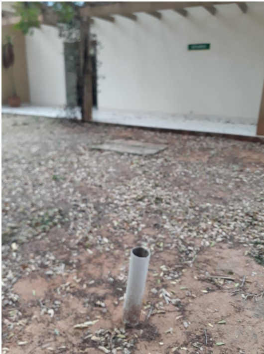
cámara séptica y pozo ciego para vestidor del hotel
