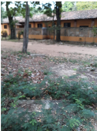
cámara séptica y pozo ciego de los dormitorios mujeres
