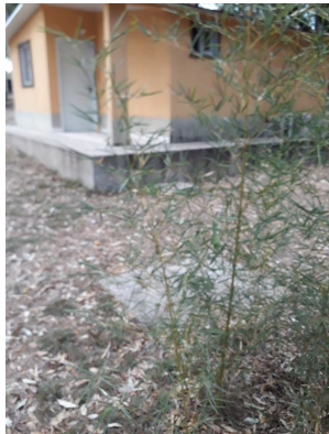
cámara séptica (izquierda) pozo ciego (derecha) Alelí
