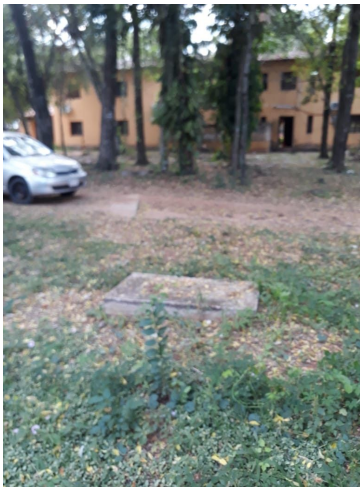
cámara séptica y pozo ciego de administración
