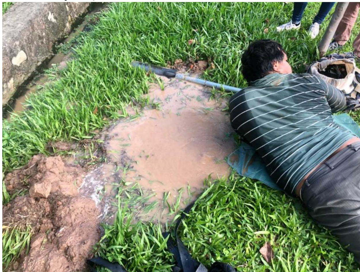
Pedro Espinola (Junta Plumber)
