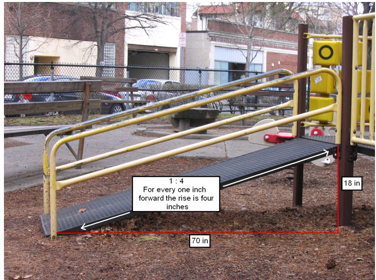
Figure 6 - Non Compliant Ramp
